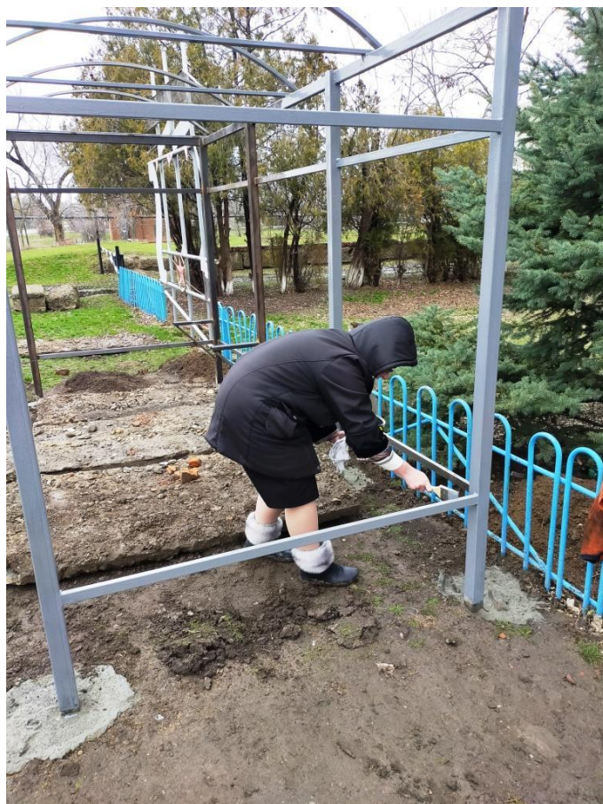
Окрашивание каркаса остановки
