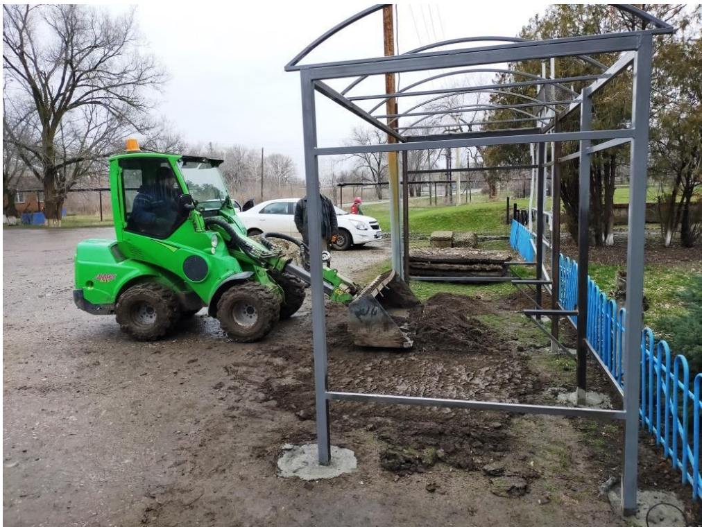
Установка каркаса остановки
